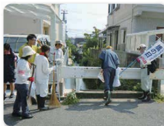
⑥橋の劣化状況を見る
